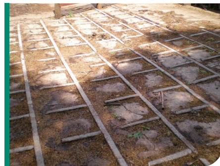
O PISO DEVE CONTER ESTRUTURAS ANTIDERRAPANTES PARA EVITAR ESCORREGÕES E QUEDAS.
